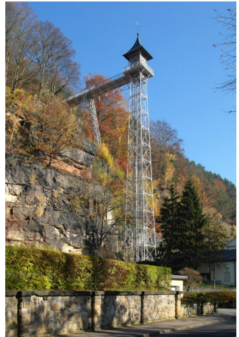
Aufzug mit Steg - Bad Schandau
