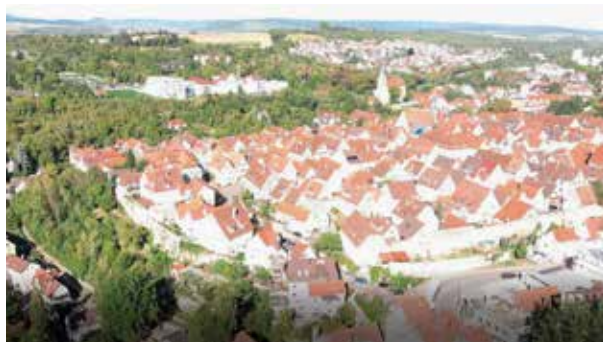
Altstadt Marbach – Wärmesituation Bestand
